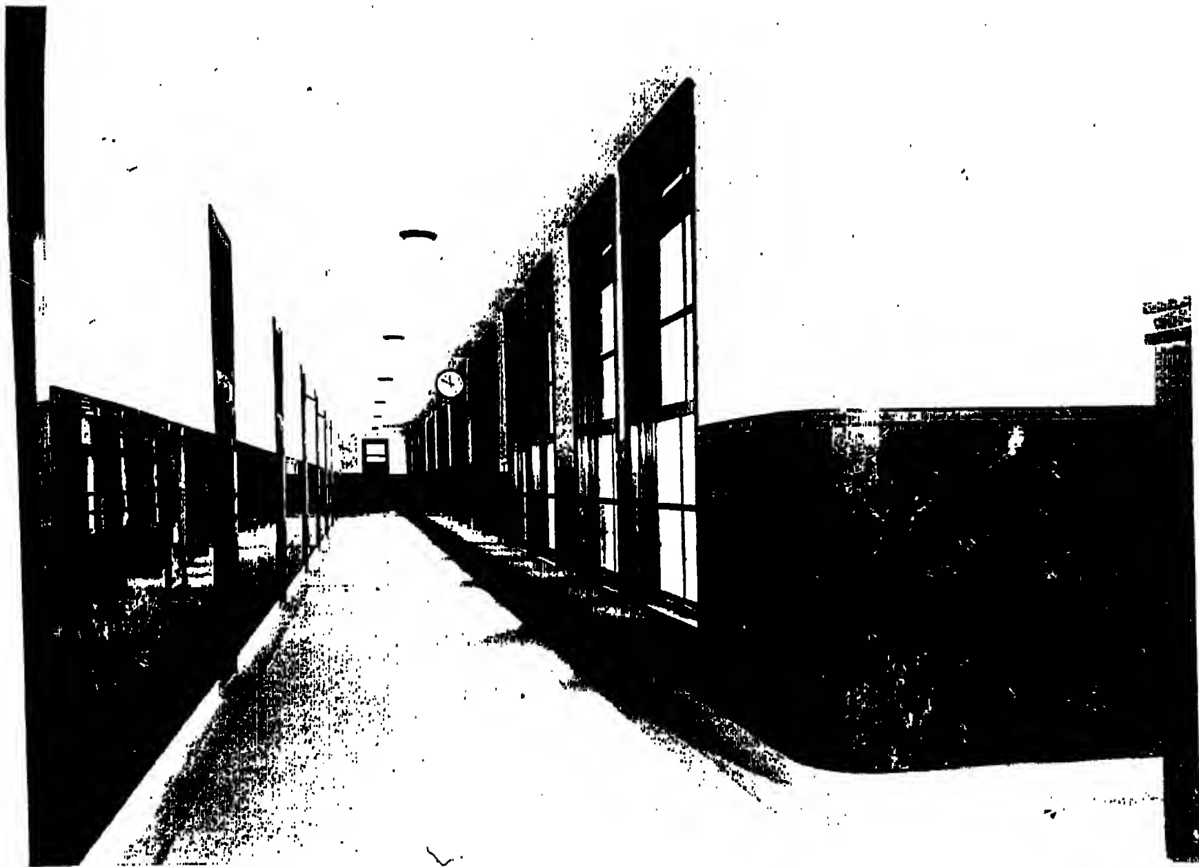
VISTA DA GALERIA DO PAVIMENTO TIPO
